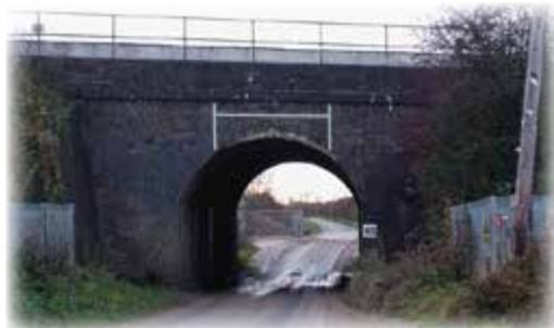
El puente Bridego Bridge, el lugar del robo
